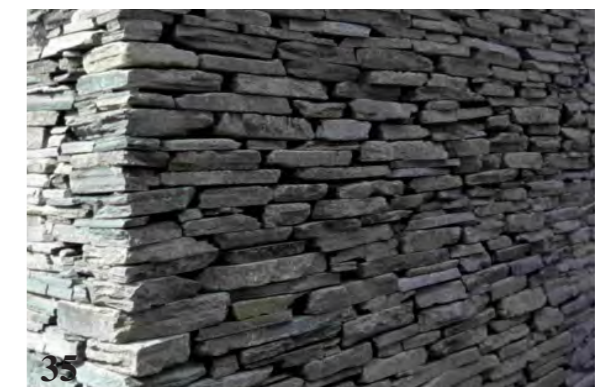
Kuva 34: Hirsipaneelia. Kuva 35: Luonnonkivimuurausta.
