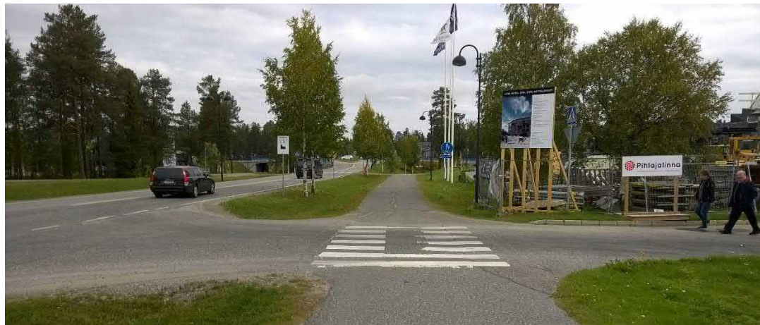
Kuva 17. Liittymä hotelliin Levintieltä (kt 79), pyörätien ylityspaikka
