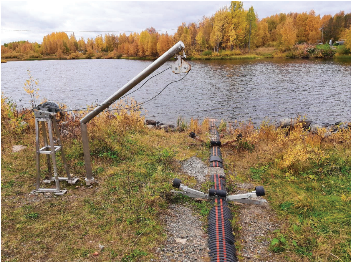
Kuva 3-1. Nykyinen, toimimaton veneensiirtolaitteisto.
