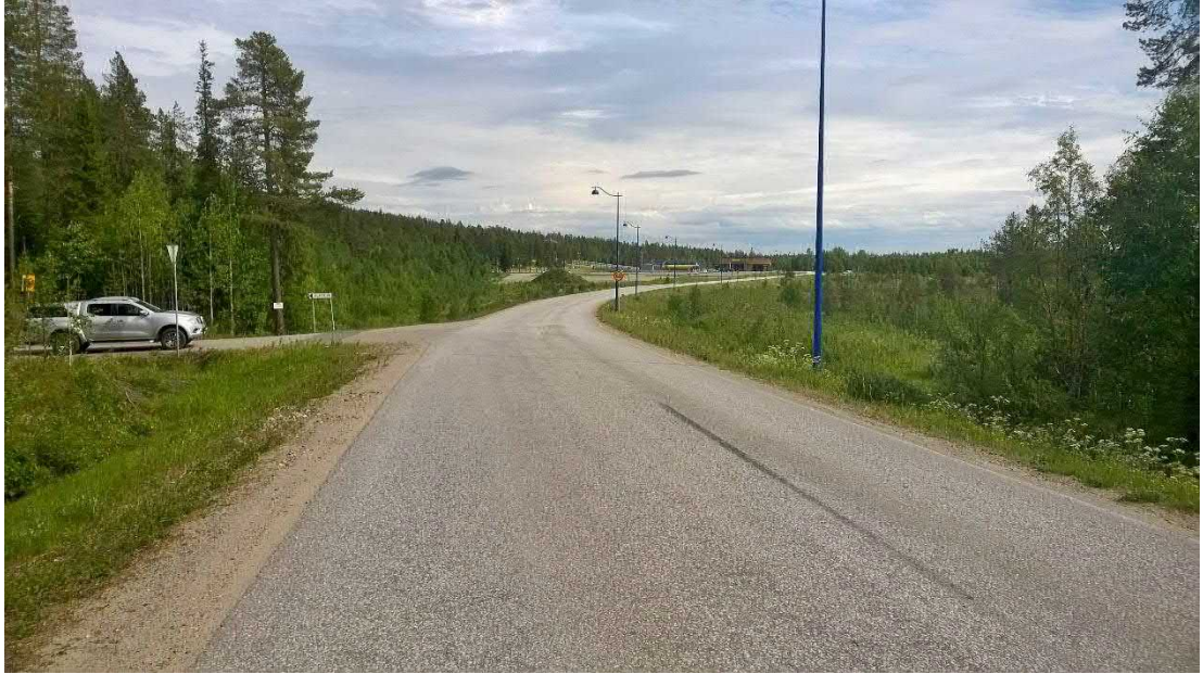
Kuva 8. Näkymä itään, Levin ympäristie, Etelärinteen ala-asema taustalla, Hirvenpolun liittymä vasemmalla puolella (12.2.2019).
