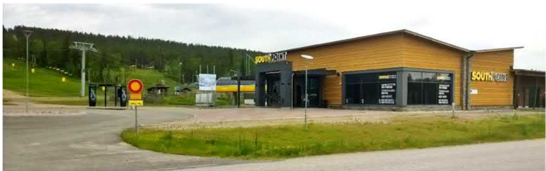
Kuva 23. Rakennettu ympäristö; South Point ja Ski Expressin linja-autopysäkki
