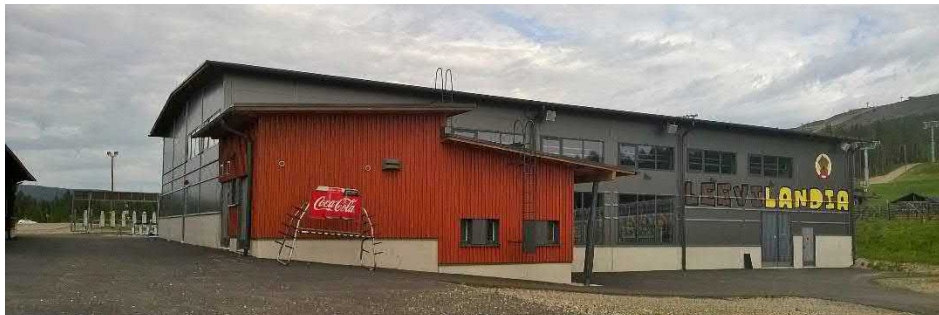
Kuva 24. Rakennettu ympäristö; etelärinteen ala-asema (24.6.2020)
