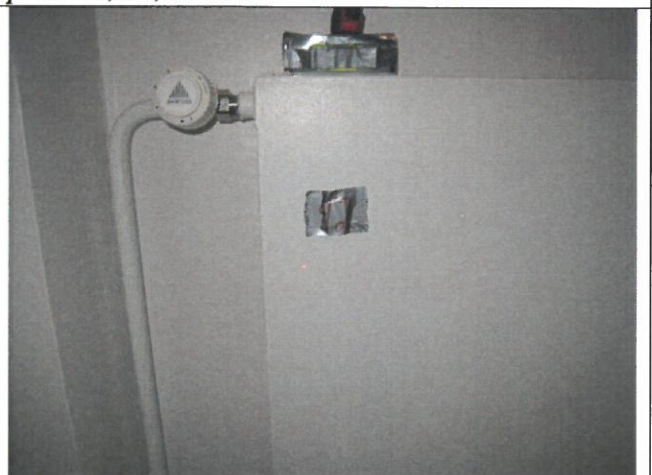
Kuva 42. RTG42, 2-lamellinen teräslevypatteri kytkentäosien laidalta, s = 1,5 mm.
