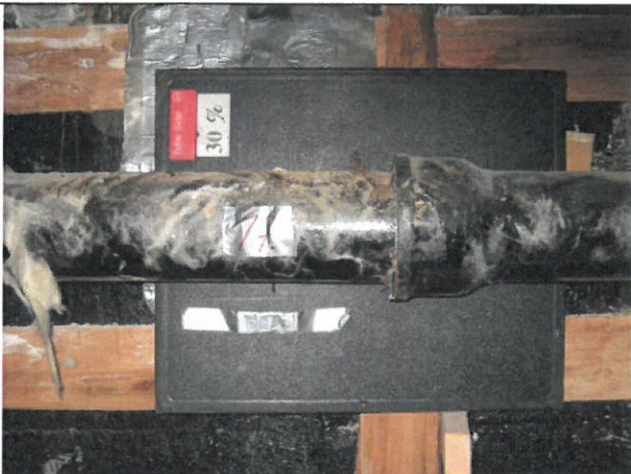
Kuva 17. RTG17, Vaakaviemärilinjan putkiosat 112/6,0 mm.
