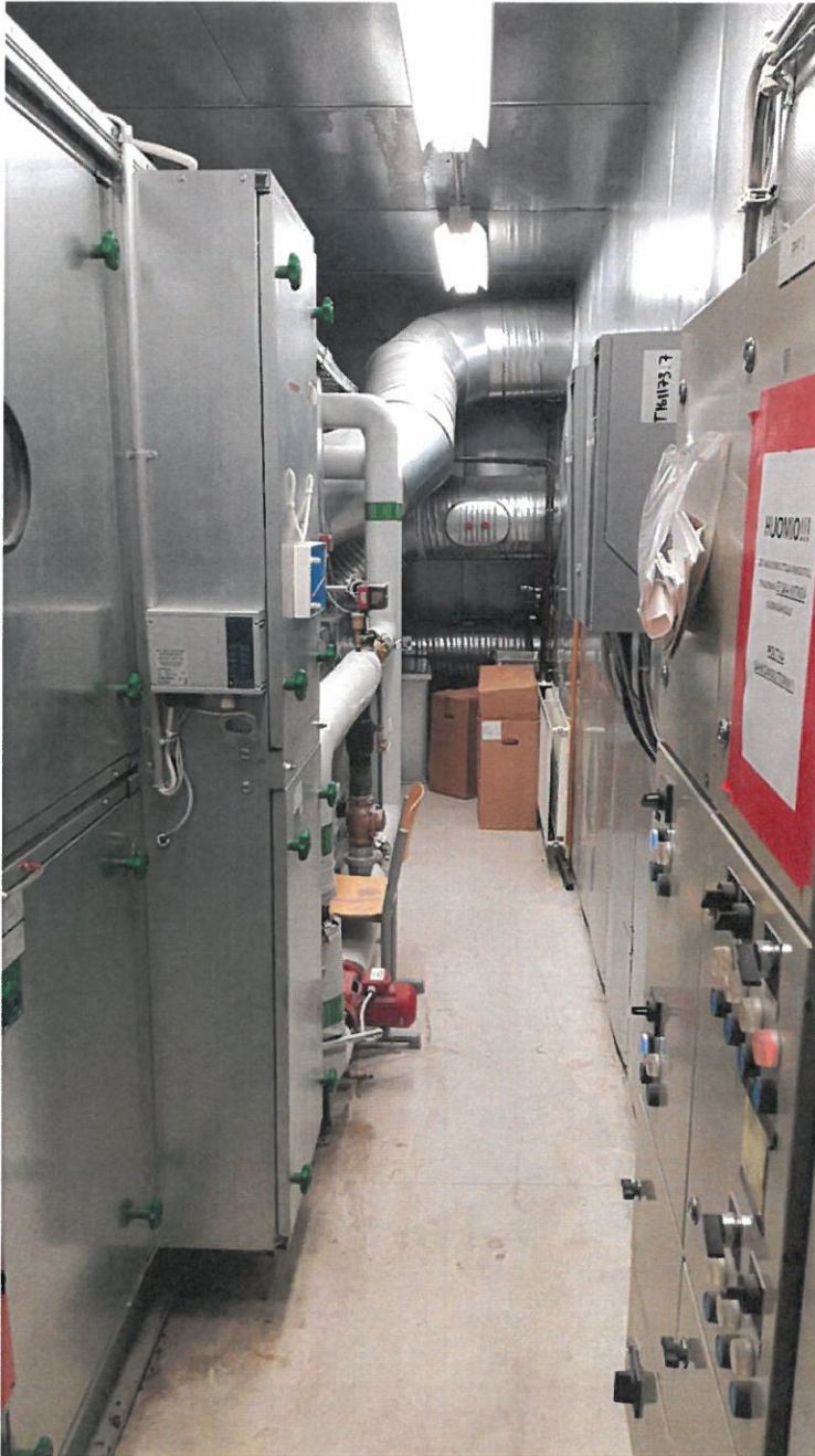
Kuva 11. Luokkatilojen IV-konehuoneen lämpöjohdot
