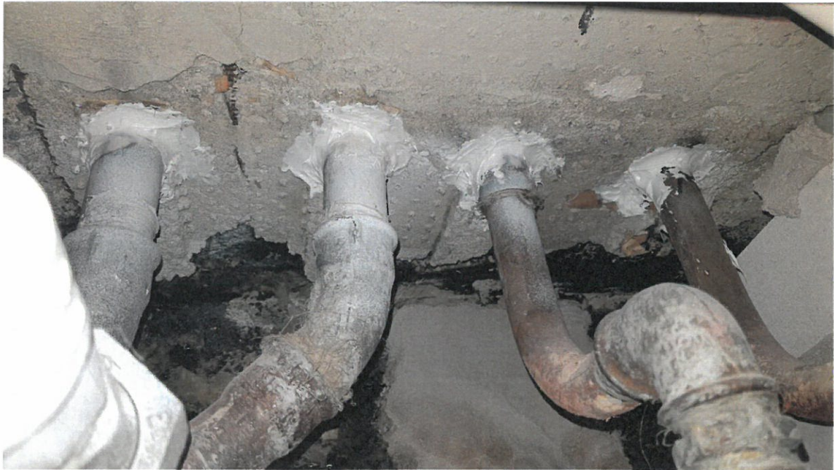
Kuva 5. Vanhempia putkia kellarikerroksessa.
