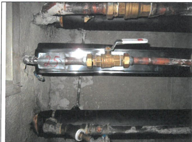
Kuva 25. RTG25, Lvk-runkohaara 22/1,2 mm.
