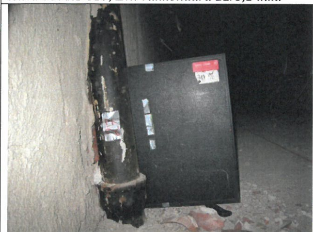
Kuva 27. RTG27, Viemäriinlinjan pystyputkiosat 112/6,0 mm.
