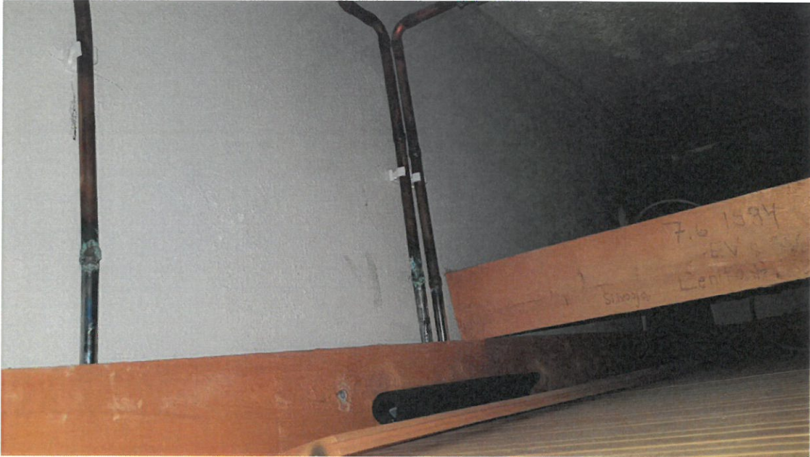
Kuva 17. Korroosiota liikuntasaliosan alakerran pesuhuoneen vesijohdoissa alakaton sisällä.
