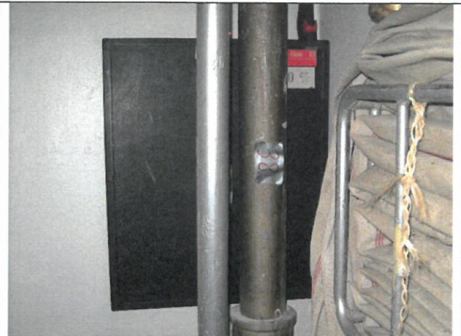
Kuva 38. RTG38, Sadevesiviemäriin suora pystyputkiosa 80/5,0 mm.
