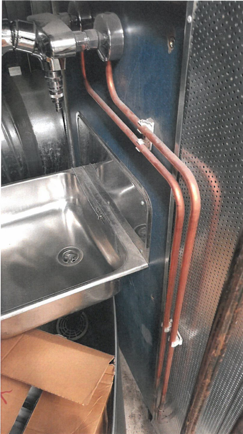
Kuva 23. Luokkatilojen IV-konehuoneen käyttövesijohdot menevät rakenteisiin (ei suojaputkea).
