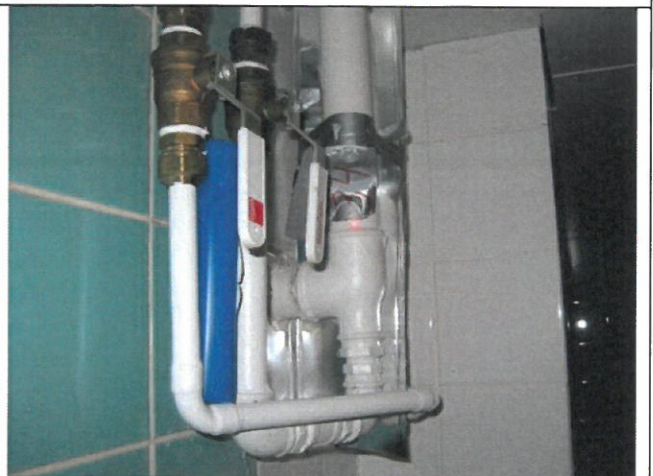
Kuva 34. RTG34, Kv-runkohaara 48,25/3,5 mm.
