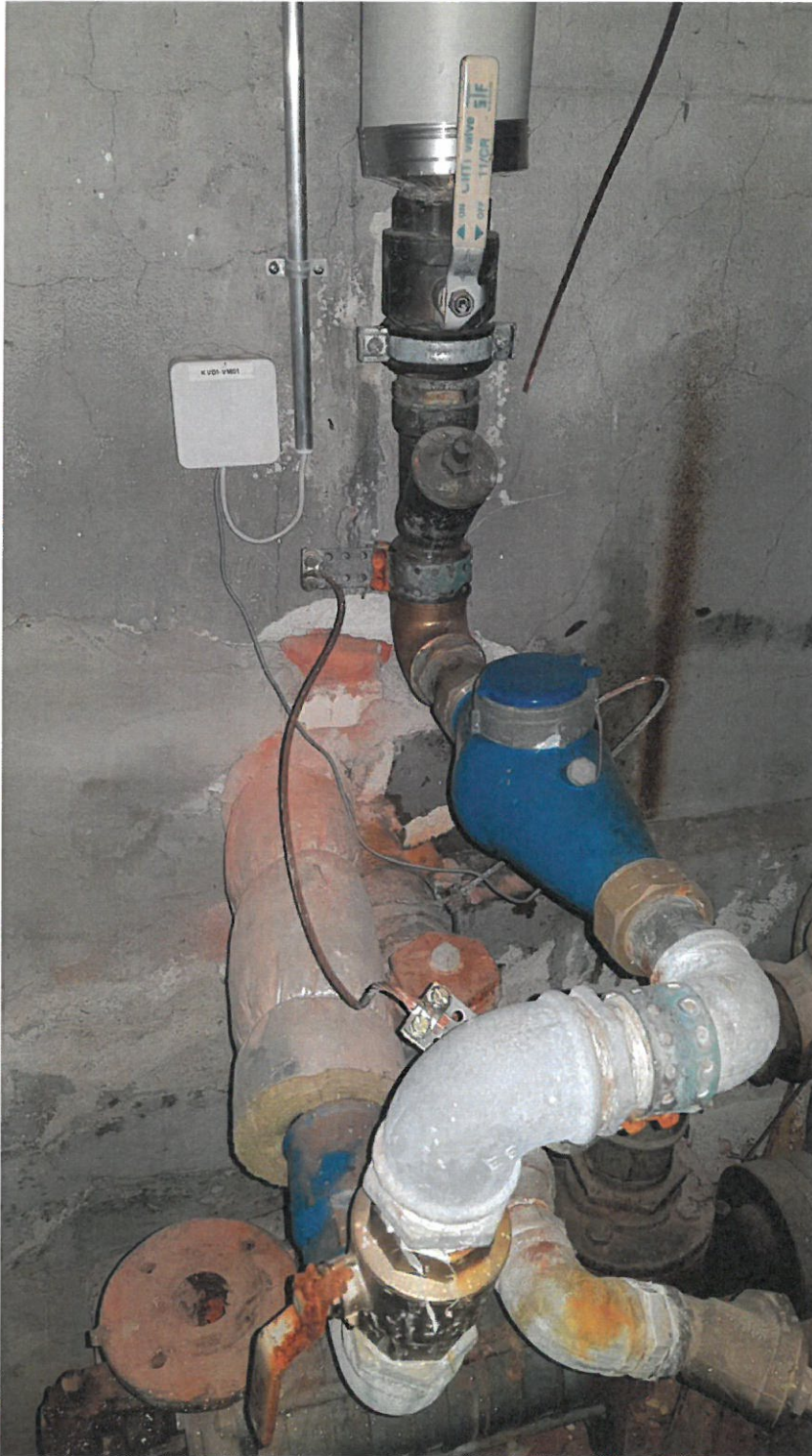
Kuva 15. Tonttivesijohto ja vesimittari
