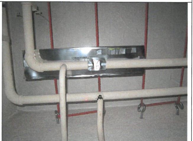
Kuva 36. RTG36, Lj-runkohaara, paluuputki 33,7/3,25 mm.
