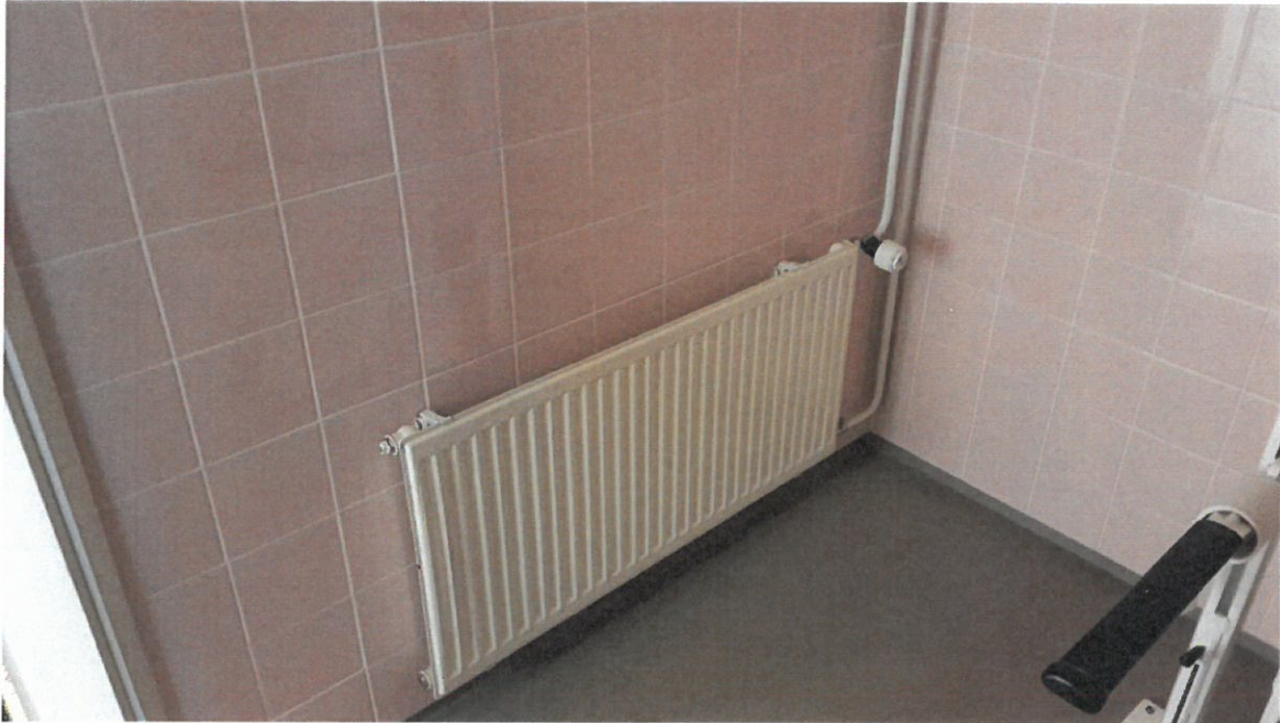
Kuva 9. 1. kerroksen aulan wc-tiloissa lämpöjohdot yläjakoisesti.
