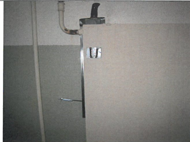
Kuva 37. RTG37, 1-lamellinen teräslevypatteri kytkentäosien laidalta, s = 1,5 mm.
