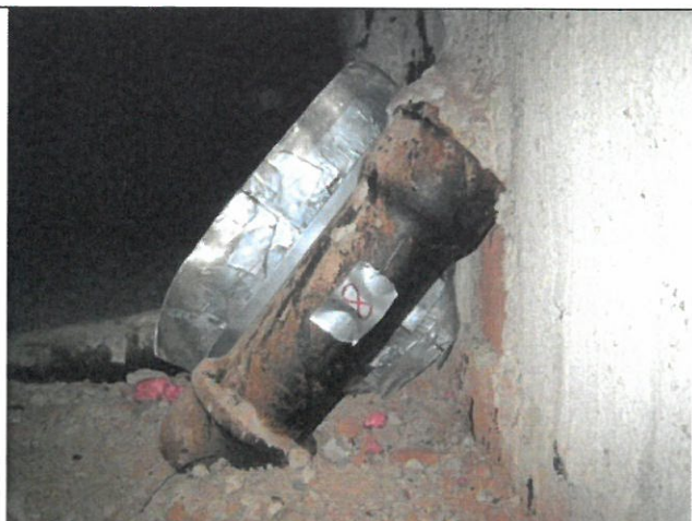
Kuva 8. RTG8, Viemärilinjän suora putkiosa 112/6,0 mm.
