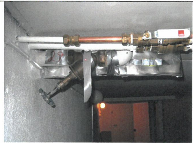
Kuva 29. RTG29, Kv-runkohaara 48,25/3,5 mm.
