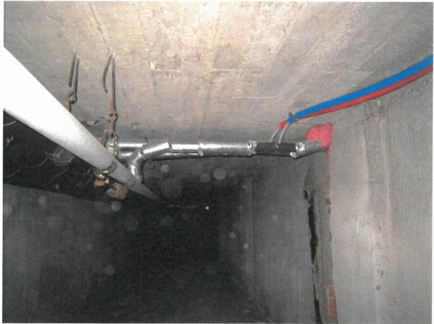
Kuva 3. Koulurakennuksen kellarikerroksen putkikanaaliosuuksien katon rajassa kulkevat kylmän käyttöveden runkohaarat ovat pääosiltaan kupariputkella uusittuina. Putkikanaalista kohti huonetilojen vesipisteitä kulkevat käyttövesiverkoston kytkentähaarat ovat samoin pääosiltaan kupariputkella uusittuina.
