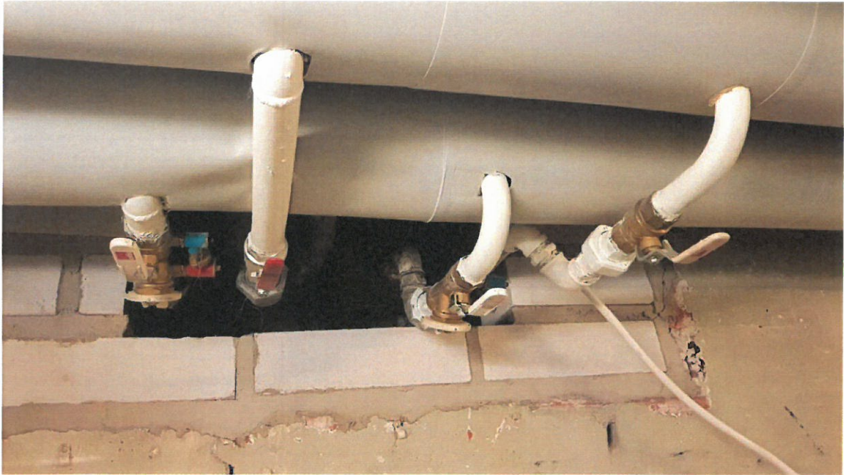
Kuva 4. Uusittuja putkistoja kellarikerroksessa, liitos vanhempaan putkistoon
