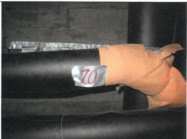
Kuva 10. RTG10, Lvk-runkohaara 22/1,2 mm & 17/1,0 mm.
