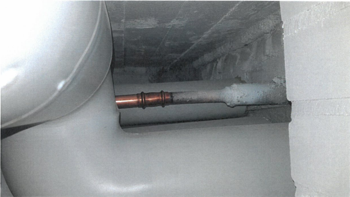
Kuva 14. Uusittu lämpimän käyttöveden kiertojohto liitetty vanhaan putkeen
