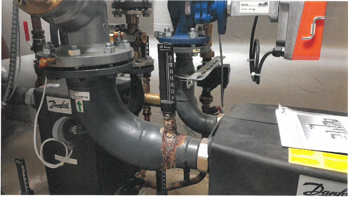
Kuva 2. Korroosiota kaukolämmön alajakokeskuksessa
