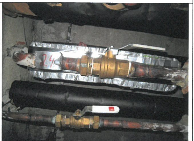
Kuva 24. RTG24, Lv-runkohaara 36/1,5 mm.
