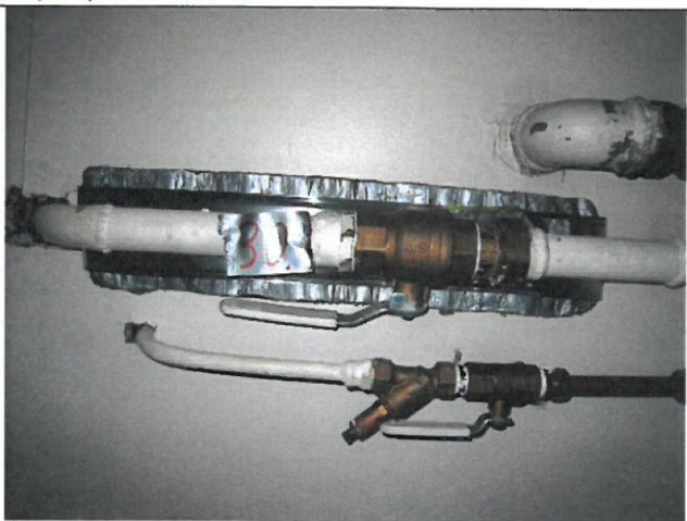
Kuva 30. RTG30, Lv-runkohaara 36/1,5 mm.
