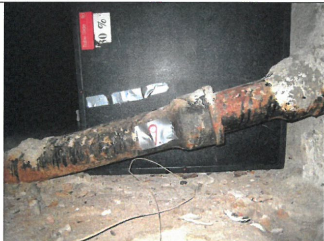
Kuva 9. RTG9, Viemärilinjän vaakaputkiosat 80/5,0 mm.
