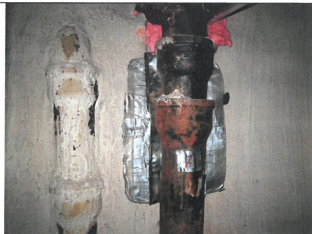
Kuva 7. RTG7, Pystyviemärilinjän putkiosat 112/6,0 mm.
