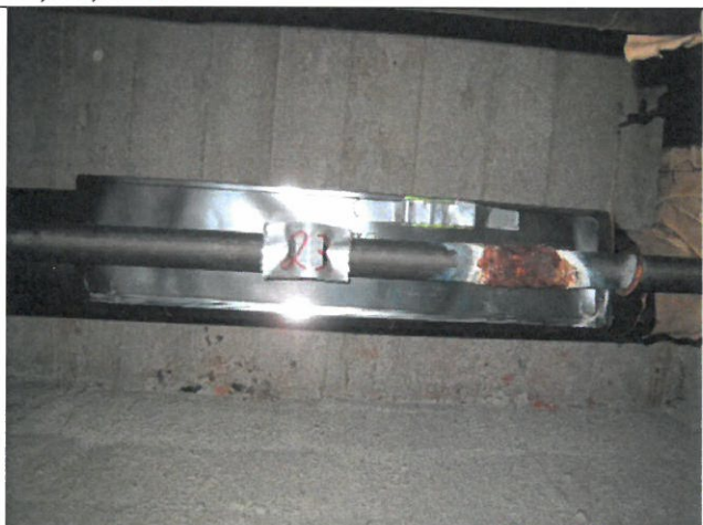
Kuva 23. RTG23, Kv-runkohaara 33,5/3,25 mm.
