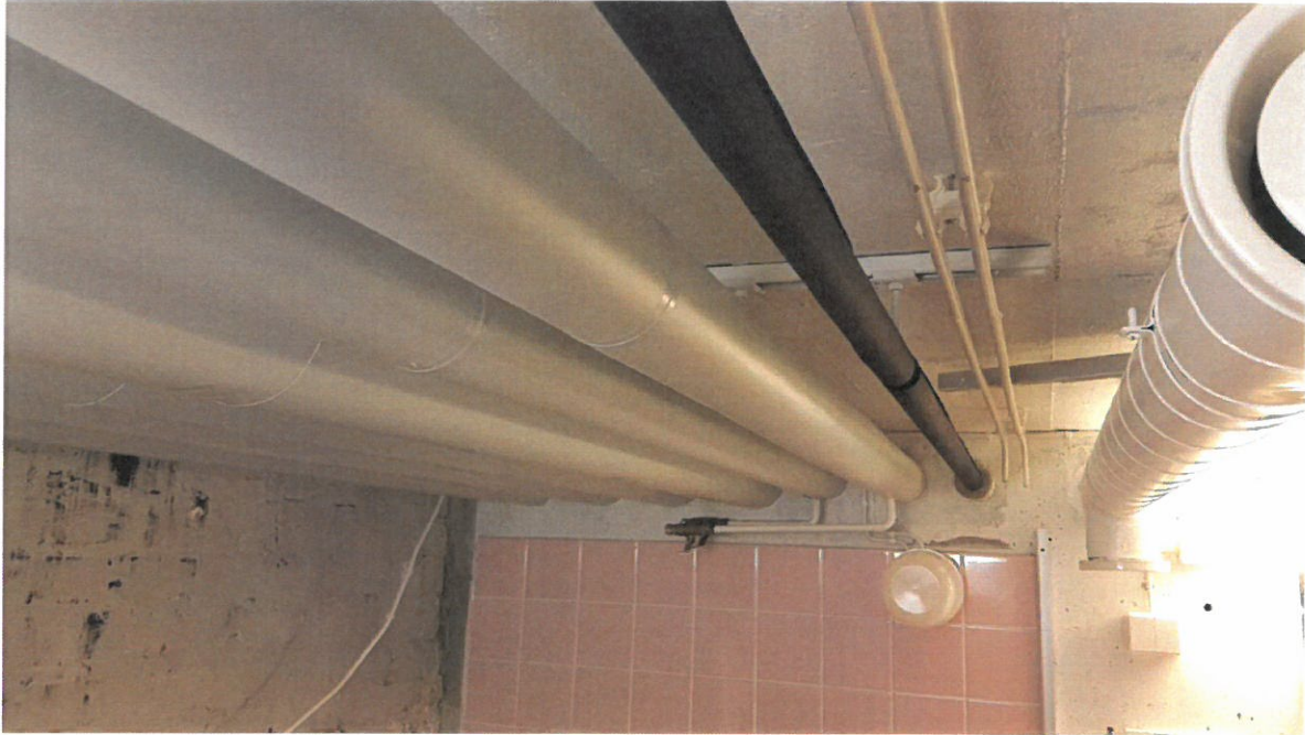
Kuva 16. Käyttövesiputkia kellarikerroksessa. Uusittu kiertovesijohto eristetty solukumieristeellä.
