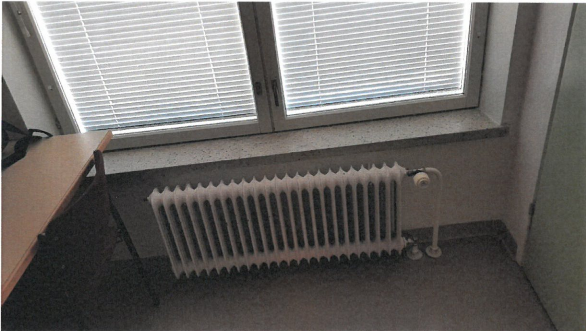
Kuva 10. Esimerkki alkuperäisistä lämmityspattereista sekä peruskorjauksen yhteydessä uusituista patteriventtiileistä
