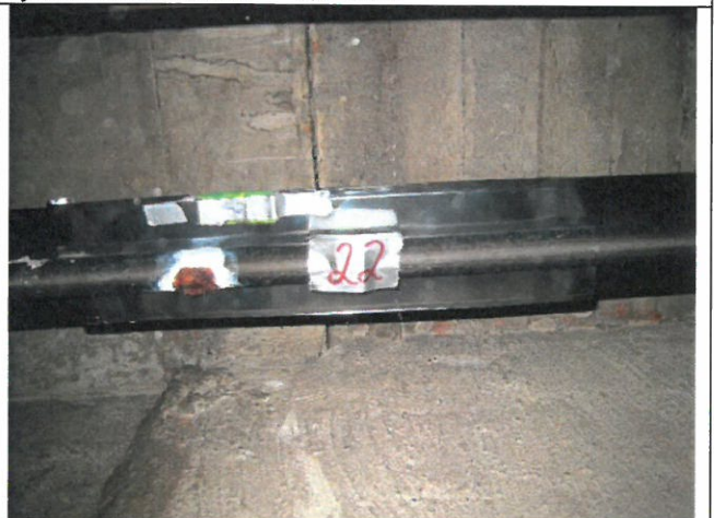
Kuva 22. RTG22, Kv-runkohaara 33,5/3,25 mm.
