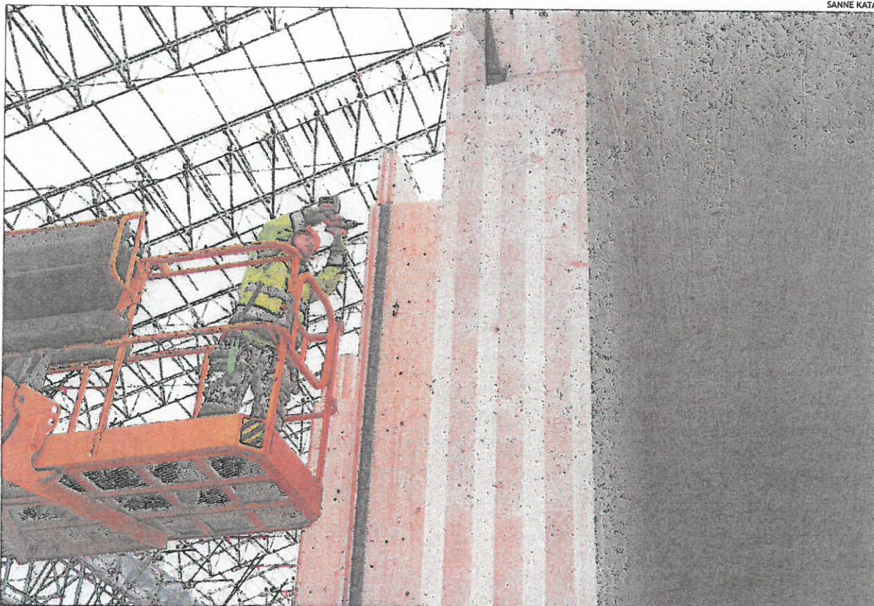
Helsingin rakentuvan Hopealaakson päiväkodin massiivipuinen runko rakentui lähes valmiiksi vain kahdessa kuukaudessa. Työharjoittelija Dmitri Tumanov viimeisteli sitä toissa viikolla.
